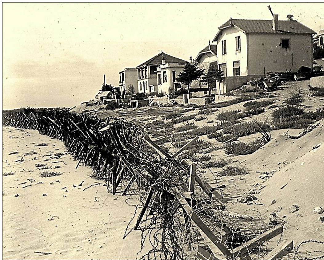
Au départ des soldats allemands en août 1944, certaines villas qui n'avaient pas été détruites ont conservé le réseau de fils de barbelés qui les isolaient de la plage. PHOTO EDMOND ASTRUC
